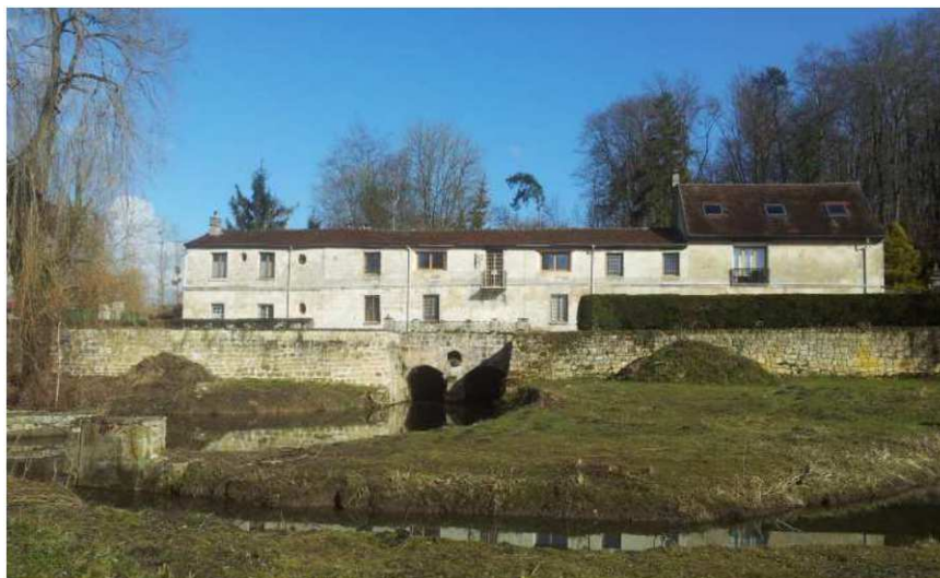
Moulin vu de l'aval Source : SINBIO
